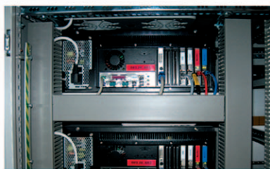
Rys. 2. Przykład poziomu procesowego systemu MASTER (ogniwo, bramka, szafa automatyki)
