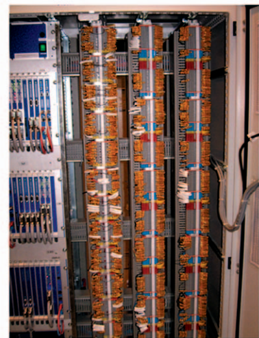
Rys. 2. Przykład poziomu procesowego systemu MASTER (ogniwo, bramka, szafa automatyki)
