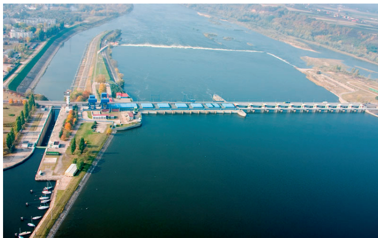
Fot. 1. Widok stopnia wodnego Włocławek od strony wody górnej
